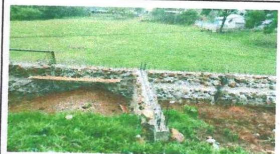
Foto 2: FINALIZACIÓN DEL MURO DE CONTENCIÓN DE 40 METROS Y SE AGREGARON 3 REFUERZOS DE 4 METROS DE LARGO CADA UNO, HACIENDO UN TOTAL DE 12 METROS ADICIONALES SEGÚN EL
