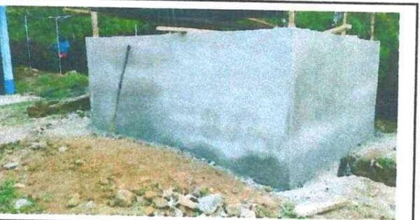
Foto 5: EN PROCESO DEL REPELLADO INTERIOR Y EXTERIOR DEL TANQUE DE CAPTACION DE AGUA LLOVEDIZA. 10/06/2024
